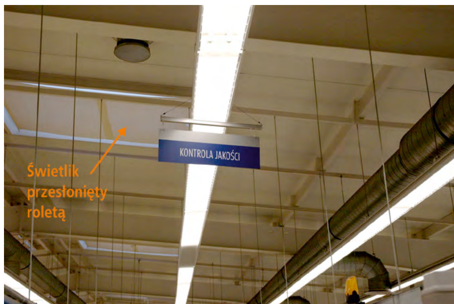
Rys. 30-1. Świetliki przesłonięte roletami w dachu pomieszczenia przemysłowego
