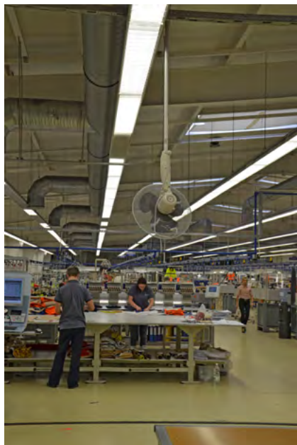
Rys. 79-3. Podwieszany wentylator w hali produkcyjnej
