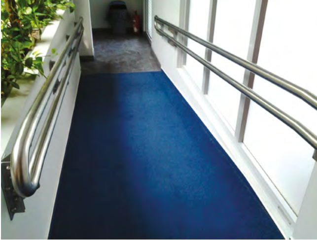
Rys. 71-1. Pochyłe dojście do stanowiska pracy wyłożone wykładziną dywanową
