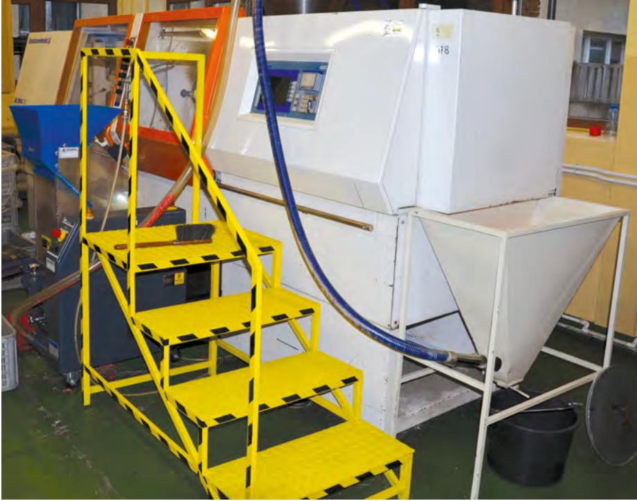
Rys. 75-1. Podest o barwie kontrastowej względem otoczenia wraz z oznakowaniem krawędzi stopni schodów ukośnymi pasami żółto-czarnymi
