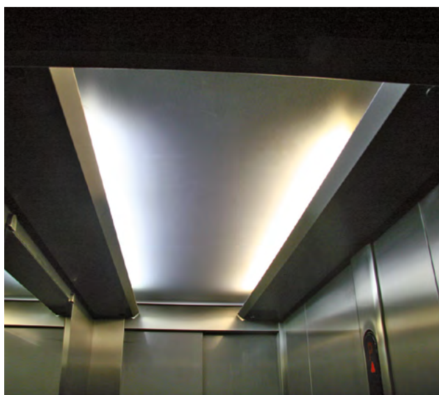
Rys. 4-1. Oświetlenie rozproszone w kabinach dźwigów osobowych
