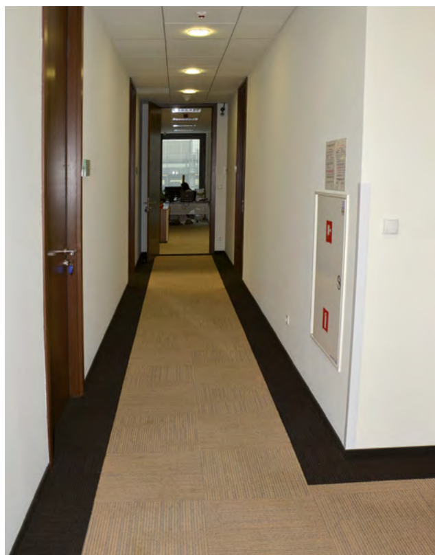
Rys. 17-1. Kontrastowe zróżnicowanie ścian i podłogi na korytarzu za pomocą kontrastowego pasa na podłodze
