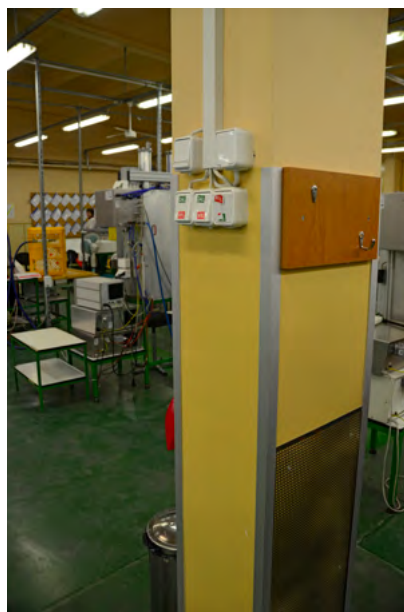
Rys. 79-4. Włęcznik systemu wentylacji z oznaczeniami funkcji wyłącz/zatącz
