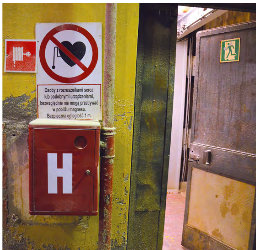
Rys. 51-1. Przykład oznakowania miejsc, w których występują pola elektromagnetyczne mogące powodować zakłócenia w funkcjonowaniu implantów medycznych
