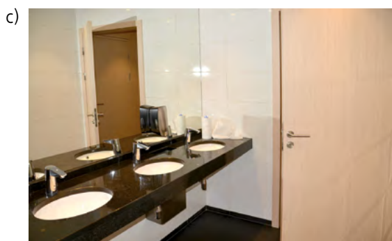
Rys. 16-1. Kontrastowe zróżnicowanie ścian i podłogi oraz wyposażenia w pomieszczeniu higieniczno-sanitarnym: a) muszla klozetowa, b), c) umywalki
