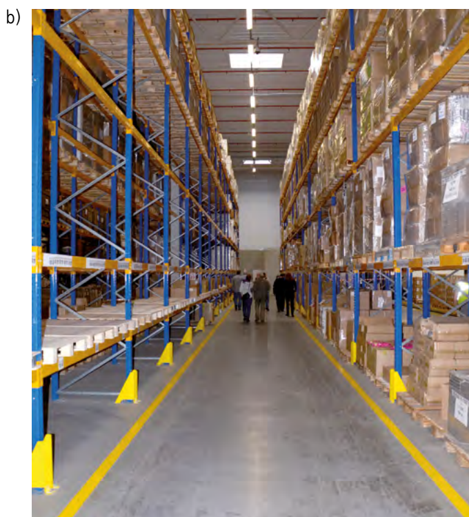
Rys. 14-1. Oznakowanie elementów regałów magazynowych z wykorzystaniem: a), b) kontrastu barwy stelaża i krawędzi półek, b) żółtej linii na podłodze oznaczającej krawędź regału
