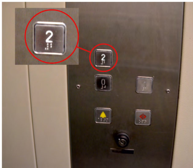
Rys. 6-1. Oznakowanie dotykowe przycisków na tablicy przyzywowej w kabinie dźwigu osobowego (wypukłe cyfry, oznakowanie alfabetem Braille'a)
