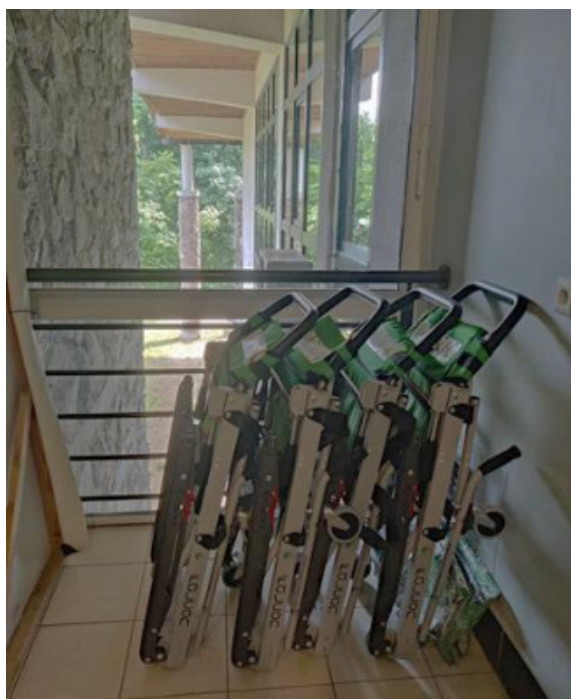
Krzeseła ewakuacyjne stojące przy klatce schodowej.
