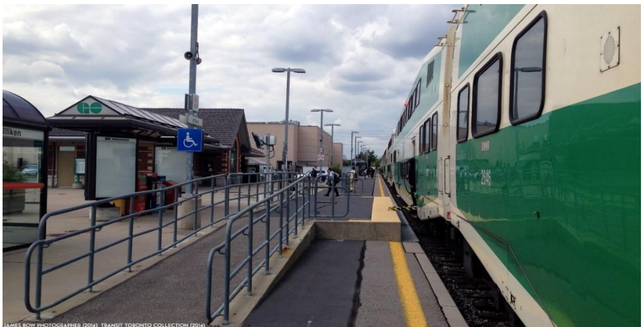
Rys. 51. Widok podwyższenia peronu na stacji Milliken GO w Toronto
