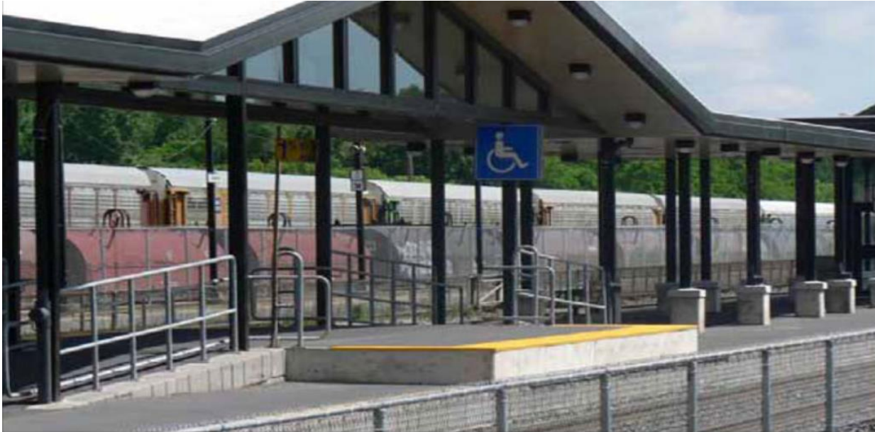
Rys. 52. Widok podwyższenia peronu na stacji Milliken GO w Toronto
